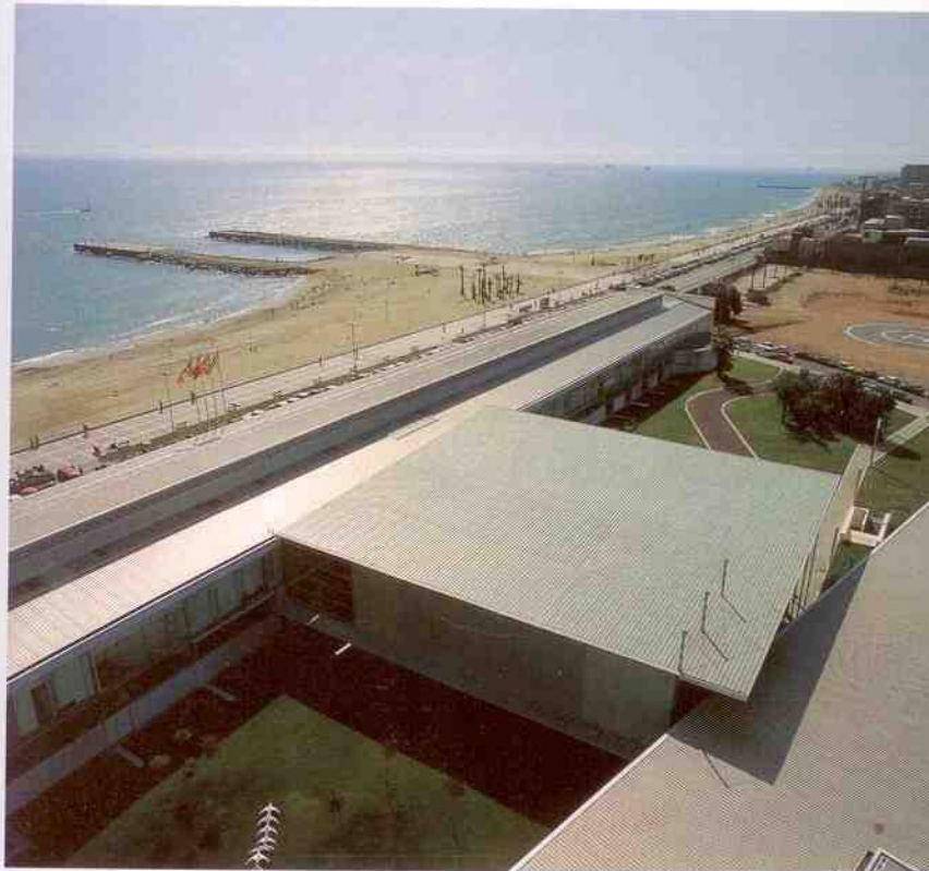
Vista aérea del Edificio de Consultas Externas.
